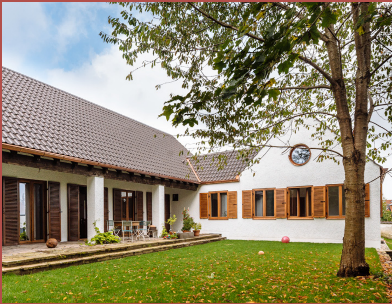
1a. PREIS: Denkmäler: Wohnhaus Ickler, Dorfen | ARCHITEKT: 4architekten, München
